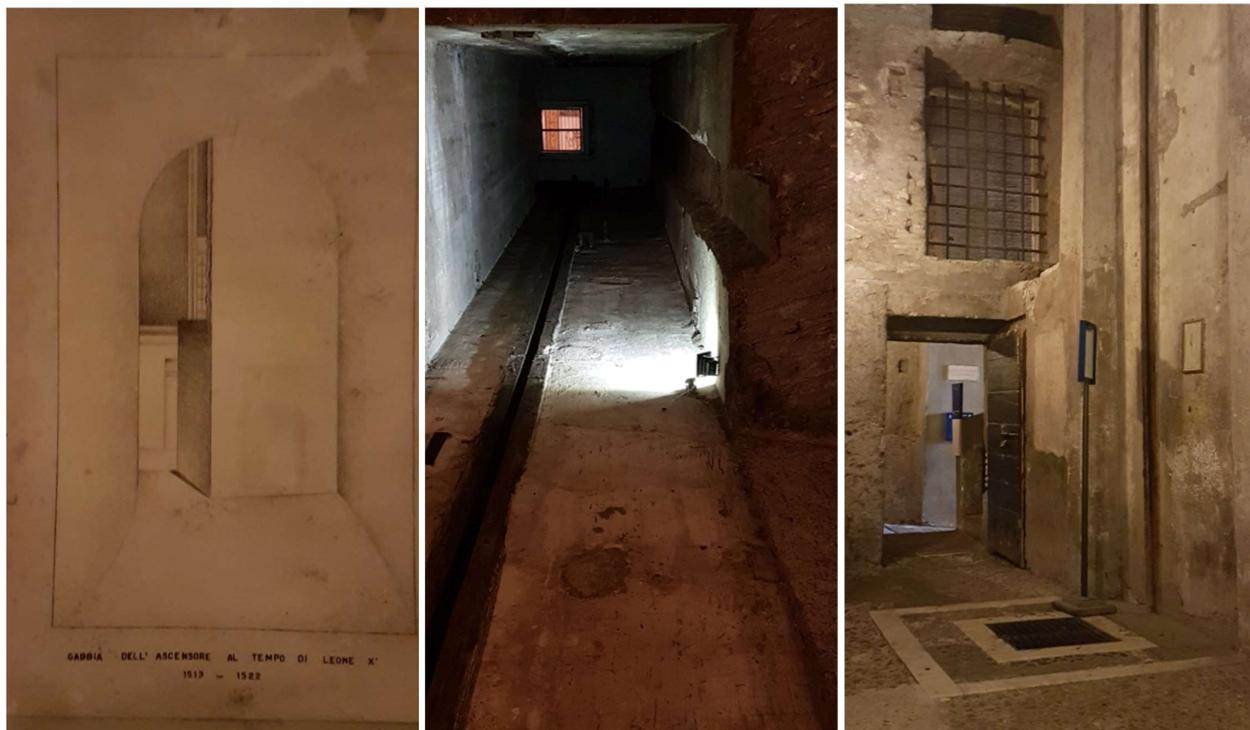
Le immagini mostrano, da sinistra a destra, uno schizzo storico dell'impianto dell'ascensore rinascimentale quando ancora occupava buona parte dello spazio di accesso alla grande rampa elicoidale; la vista dal basso verso alto del vano ricavato in epoca rinascimentale, con tanto di guida per la cabina incastrata nel muro; la griglia che copre il punto di arrivo in alto nel palazzo pontificio dell'ascensore di Leone X e la continuazione della guida nel muro sopra la griglia.
